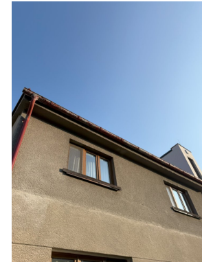
Okapy a svody jsou už bez povrchové úpravy.
