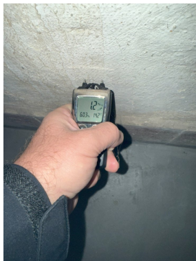
Měření vlhkosti v suterénu domu.
