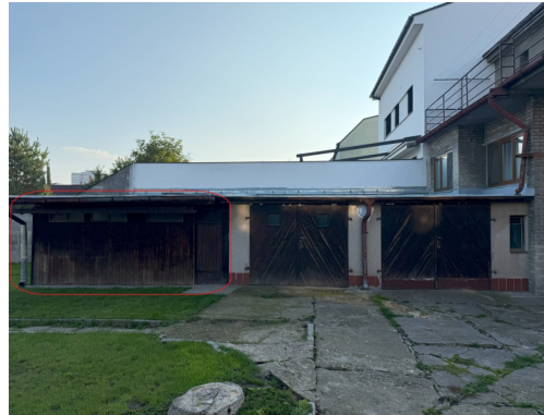
Garáž bez stavebního povolení.
