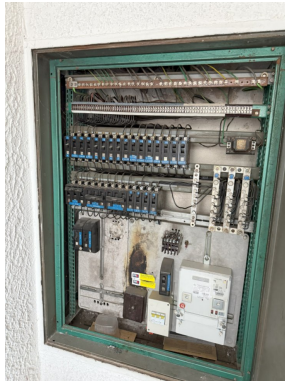
Původní rozvody elektřiny.
