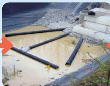
Vložení plastových akumulčních systémů
