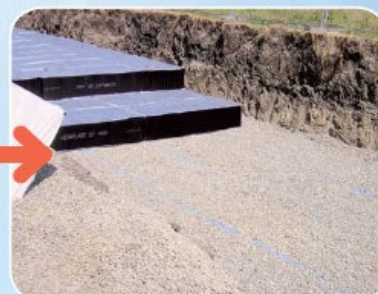
Pokládka bloků na šterkové lože s drenážním potrubím
