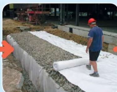
Pokládka ochranné geotextilie
