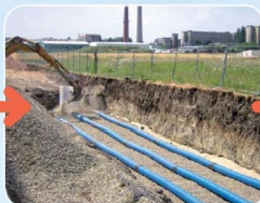
Propojení šachet drenážním potrubím a šterkování
