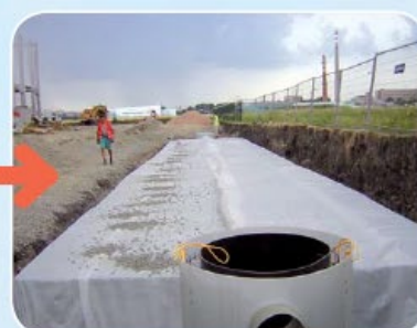
Kompletní objekt před zasypáním
