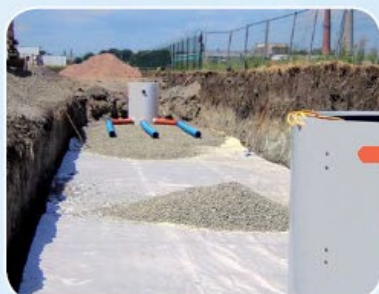
Zahájení prací - osazení šachet a geotextilie
