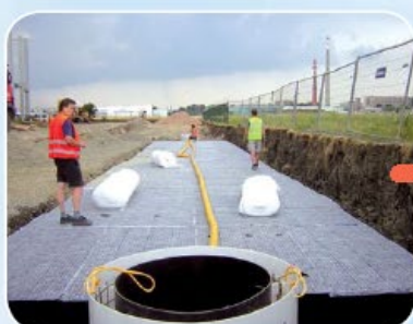
Montáž odvětrávacího potrubí
